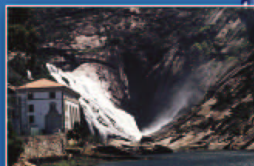
Central hidroeléctrica no Xallas • Dumbria
